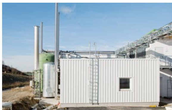
Blockheizkraftwerke (BHKW)
