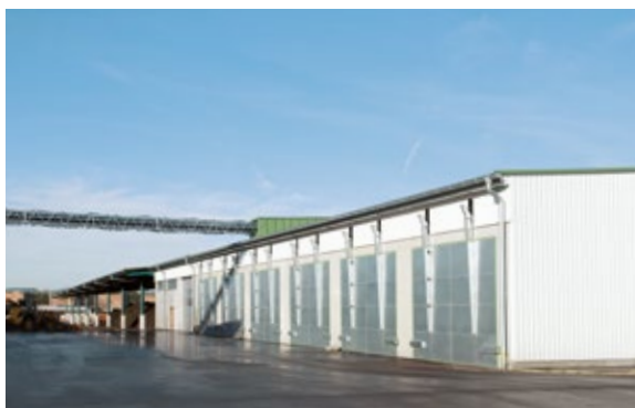
Das Herzstück der Anlage – die garagenförmig aufgebauten Fermenter
